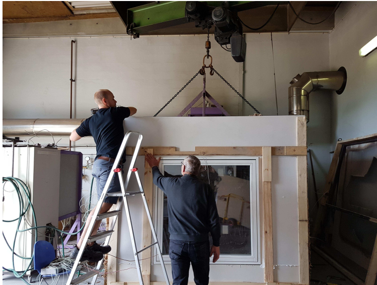
Beklædning foran isolering på test element ( for at holde på varmen )
